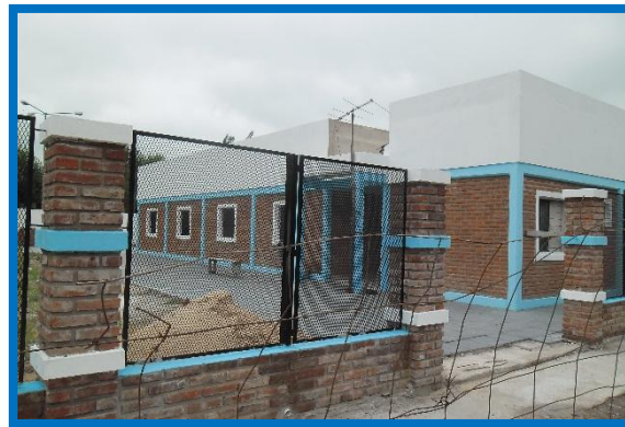
Construcción edificio del COM y del Jardín de Infantes N° 923
