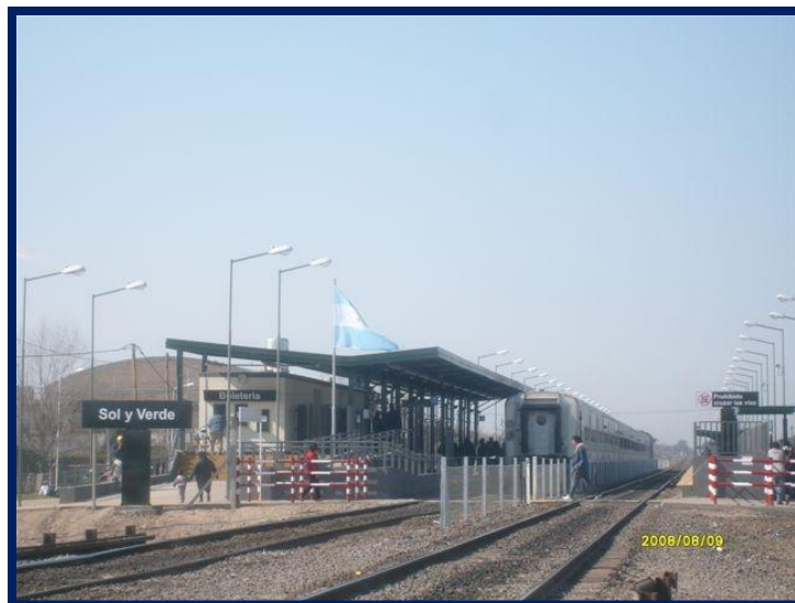
Estación “Sol y Verde” dos meses después de la inauguración
