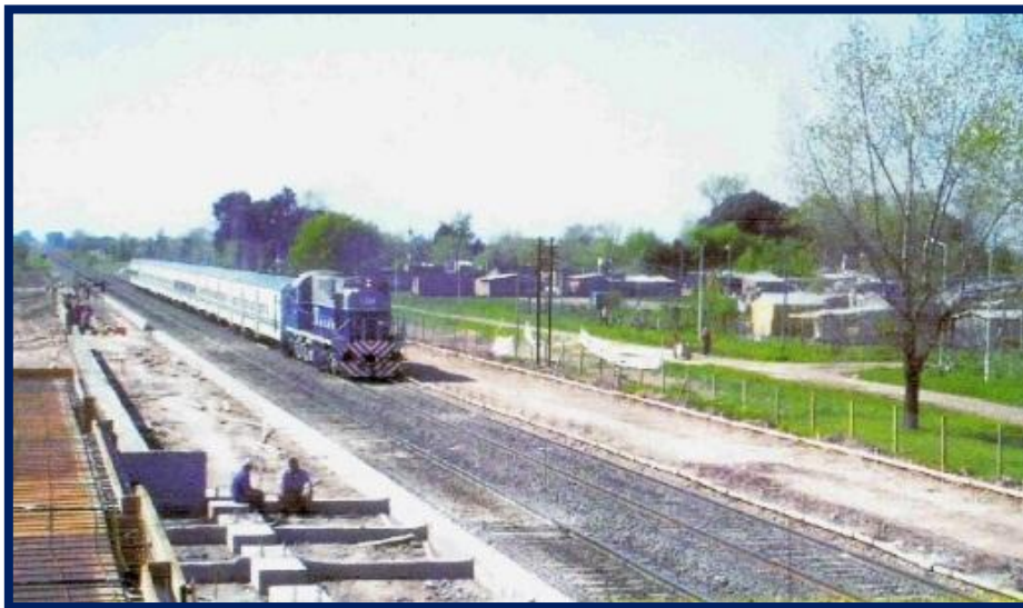
Estación “Sol y Verde” en construcción
