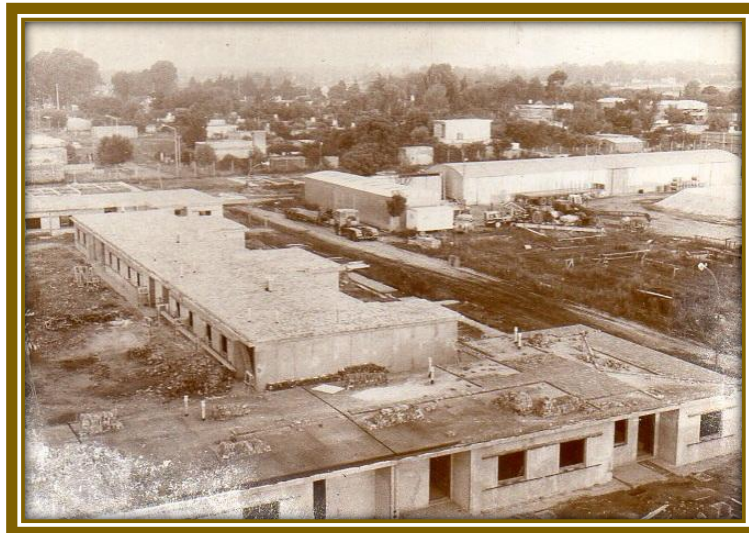
Barrio “Santa Rita” en construcción
