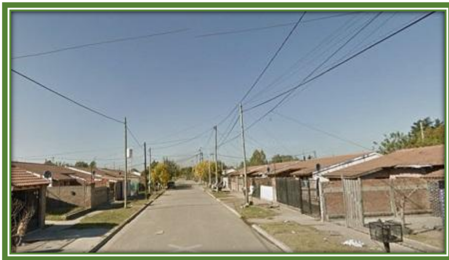
Viviendas construidas mediante Plan de Emergencia Habitacional sobre la calle Chacabuco
