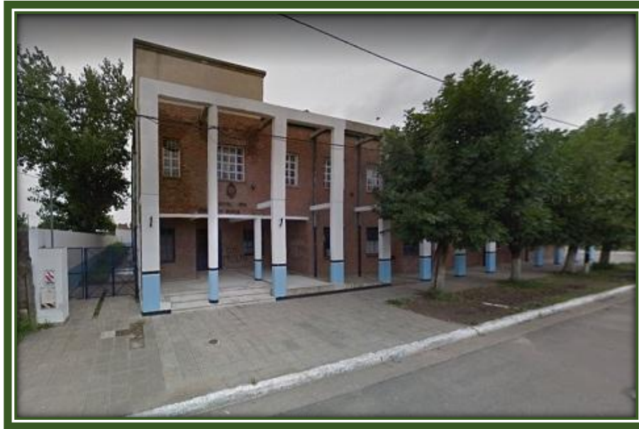
Frente Escuela Primaria N° 16 sobre calle Miller
