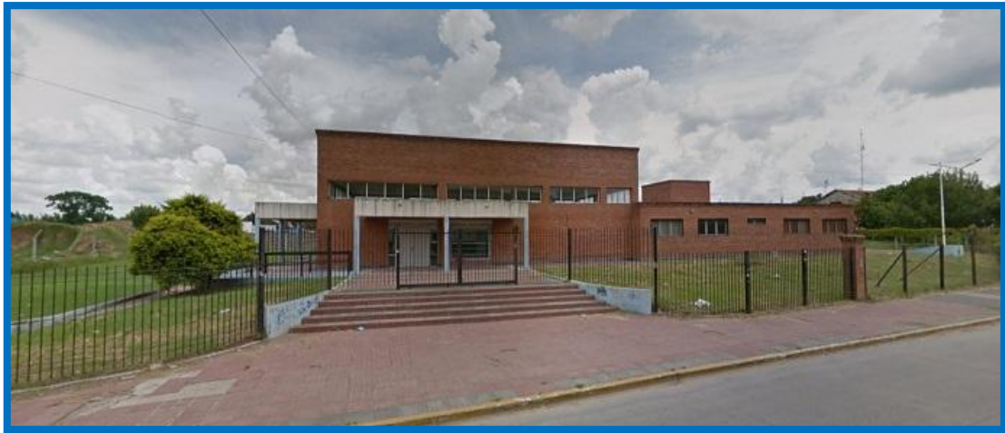
Edificio escolar sobre la calle Leandro N. Alem
