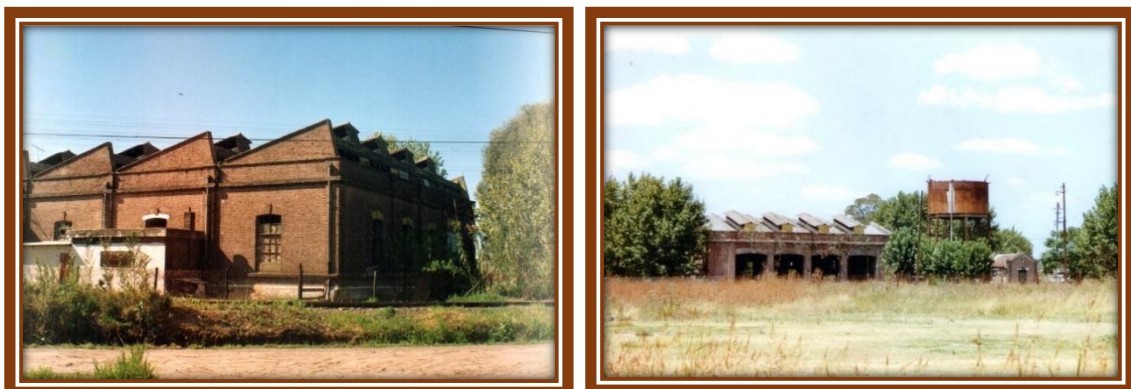
Galpón de Máquinas en 1997, visto desde la calle Fraga Y en el 2000, visto desde el terreno ferroviario o “campo de la estación”
