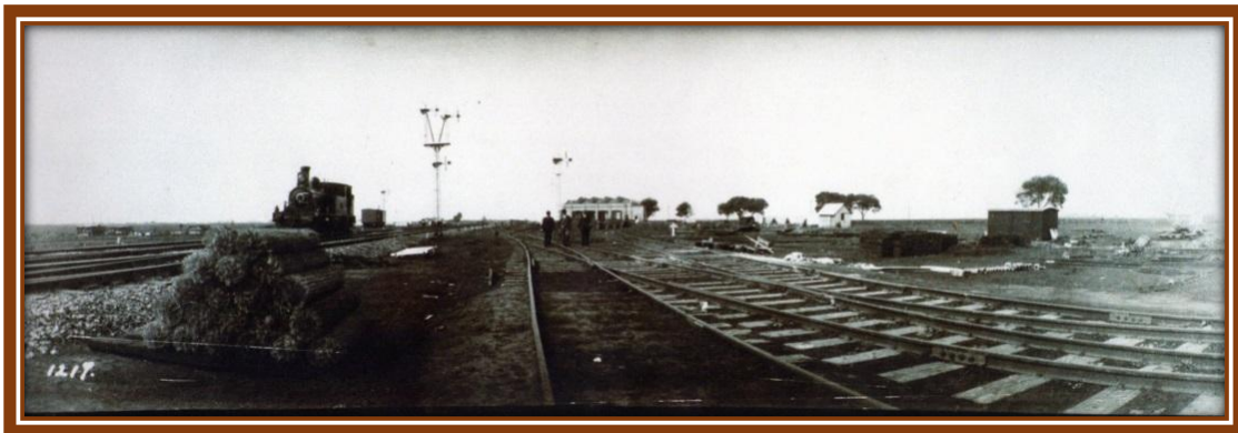
Tendido de vías y construcción del galpón de máquinas
