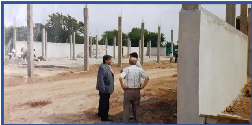
Hospital oncológico en construcción
