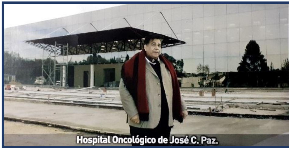
Intendente visitando las obras de Hospital Oncológico
