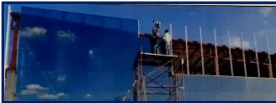
Estado de las obras exterioremente.
