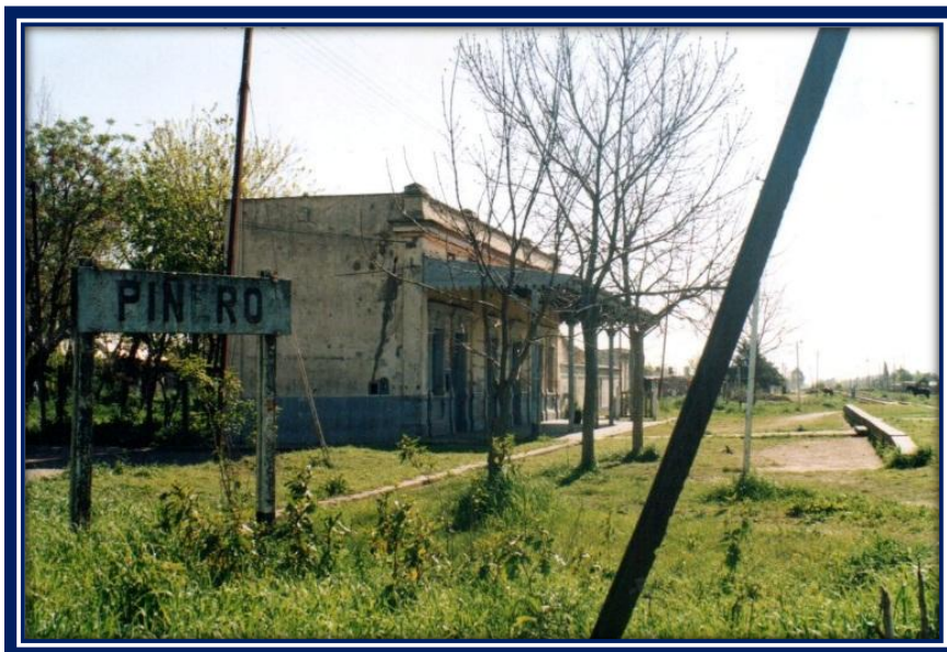
Estación Piñero (fotografía tomada en 1997)
