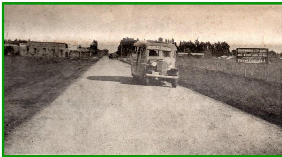
Colectivo transitando por Ruta 197 asfaltada en 1930 A la derecha: cartel de Furst Zapiola sobre las quintas en venta Detrás, a la derecha, Villa Iglesias, y a la izquierda, Villa Germano
