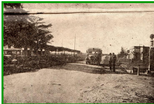
Acceso por Ruta 197 entre Villa Iglesias y Villa Germano
